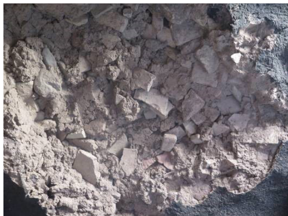
شکل ۵. قطعات آجر و سفالینه‌های به‌کار رفته در ساخت باروی چینه‌ای حصار جنوبی (مأخذ: نگارنده)
