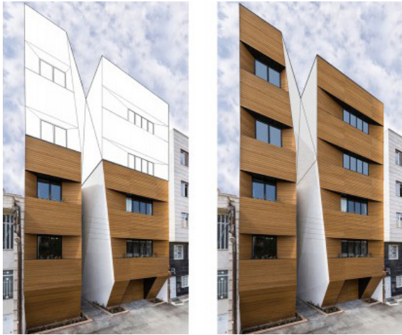
تصویر ۲۷. عدم تناسب عرض ورودی با ارتفاع بنا و مشکل بیشتر آن بعد از ساخت ۲ طبقه در آینده
