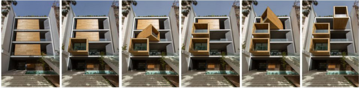
تصویر ۱۶. نمای اصلی خانه در حالت‌های مختلف باز و بسته بودن در ۳ عملکرد اتاق خواب و اتاق کار و آشپزخانه
