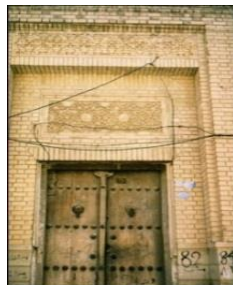
سردر ورودی منزل موسوی نسب و تزیینات آجری
