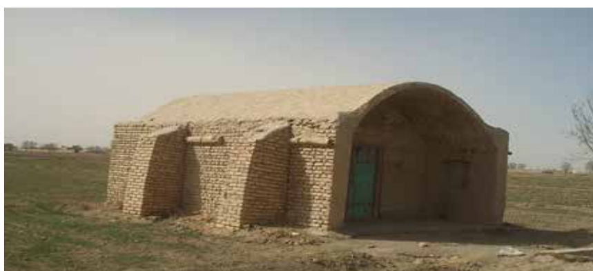
عکس ۶ افزایش دامنه‌ی اثر و عمل دیوار هو با بهره‌گیری از چوب (مأخذ: نگارندگان)
