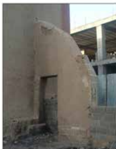
دیوار هوی دارای بازشوی یک طبقه و یک واحدی خانه استپاتیان اصفهان
