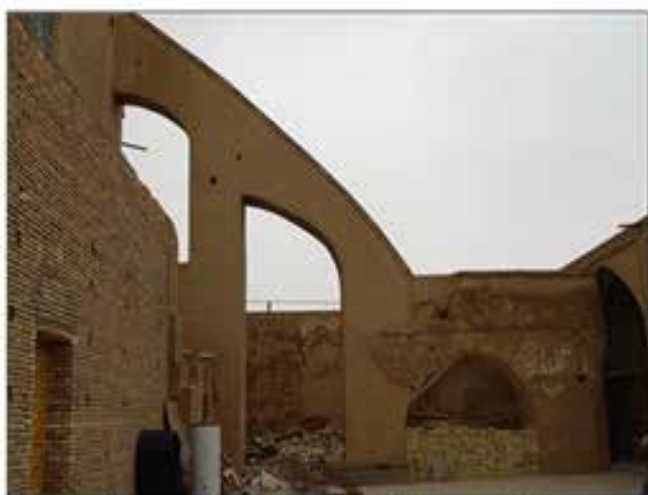
دیوار هوی دارای بازشوی دو طبقه‌ی دو واحدی مسجد جامع یزد
