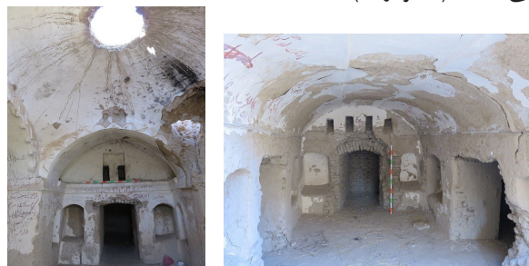
تصویر ۳. دریچه‌ی کانال‌های هوا در داخل اتاق و تالار پذیرایی به صورت جفتی و چهارتایی، در طبقه همکف، بخش مرکزی سکونتگاه قلعه‌ای ورمال (مأخذ: نگارندگان ۱۳۹۴)
