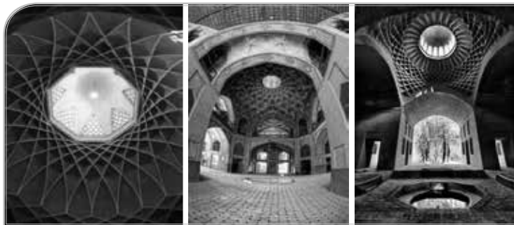
شکل ۵. نمونه هایی از روشنندان (ساختمانی در شهر یزد، کاخ هشت بهشت، عمارت باغ دولت آباد یزد)
