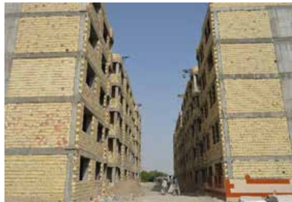
تصویر ۵. مسکن مهر در حال ساخت در بندر خمیر
